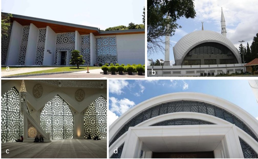
Şekil 8. Cami Cephesi Gölgelendirme Elemanları (a - Hafıza 15 Temmuz Cami-2019, b - Şakirin Cami-2009, c - Marmara İlahiyat Cami-2015, d - İTÜ Cami-2019)
