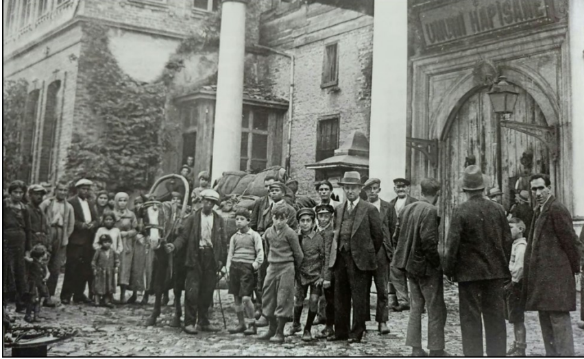
Şekil 8. Umumi Hapishane'nin kitabeli Giriş Kapısı. http://www.eskiistanbul.net
