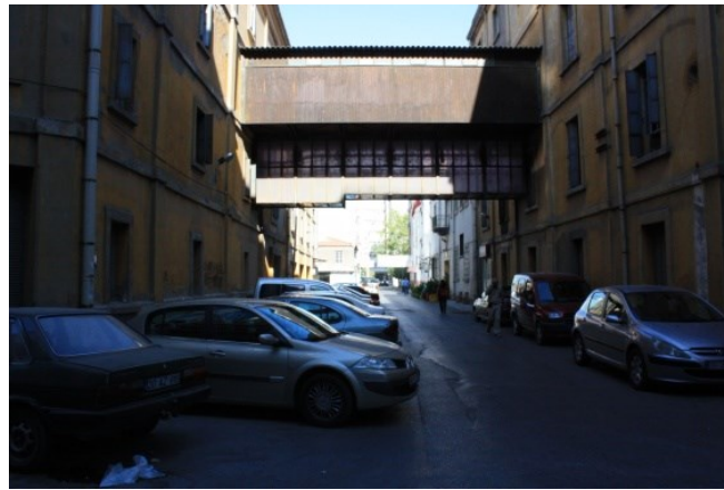
Şekil 12. Tekel depoları arasında bağlantıyı sağlayan geçiş elemanı, restorasyon öncesi fotoğrafı (Mimarlar Odası fotoğraf albümü)
