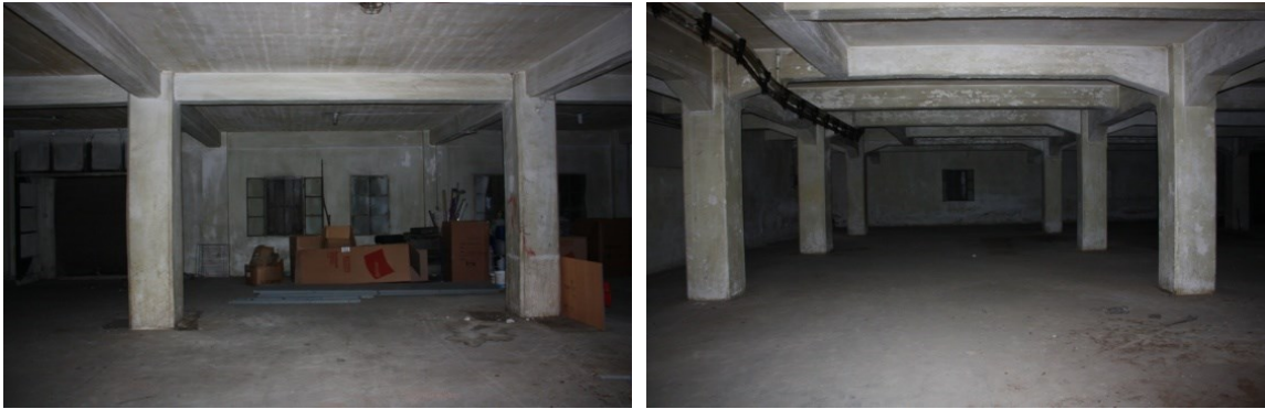
Şekil 16. Tapu Kadastro Müdürlüğü restorasyon öncesi durum (Çevre ve Şehircilik Bakanlığı fotoğraf arşivi)
