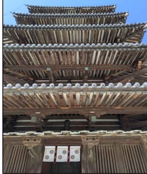
Resim 6. Beş Katlı Pagoda Ön Görünüşü (Sirikci2020).
