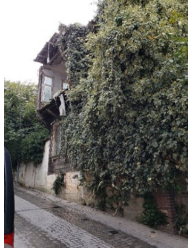
Resim 2. Üsküdar'da eski yıkılmak üzere yapı
