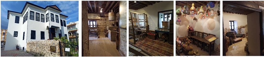
Yapının Güney Cephesi
