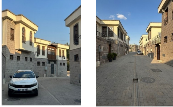
Şekil 10. Yeni evlerde yapı aralığı (Yazar tarafından)
