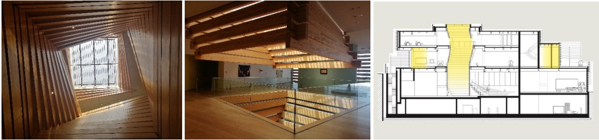
Şekil 10. Müze içine günışığı sağlayan yatay çatı ışıklığı (Koçhan, 2024), Müze içindeki günışığını gösteren kesit (Çemrek, 2020)
