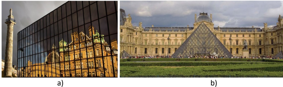
Şekil 3. a) Emerson Chambers'ın Newcastle'da cam cepheli bir binadaki yansıması ve b) Louvre Müzesi piramidinde şeffaf malzemeler kullanılarak görsel sürekliliğin sağlanması (Tabrizi ve Abdelmonem, 2024).
