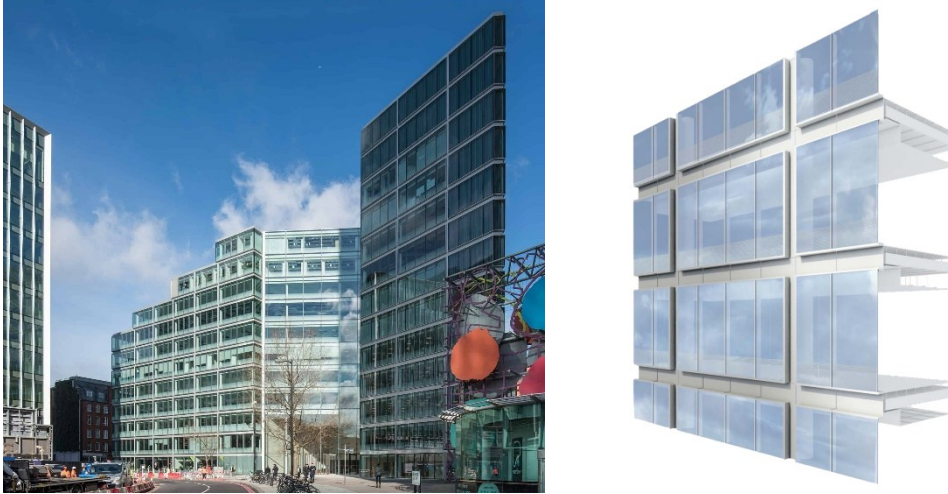
Şekil 3. Verde SW1 binasının cephe sistemi (URL-4).
