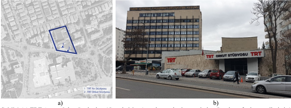
Şekil 1 (a) TRT Arı ve Orkut Stüdyoları (Google Maps'ten alınmış harita üzerinden Gürel tarafından üretilmiştir.) (b) Yapı kompleksinin mevcut durumu (Gürel, 2025).
