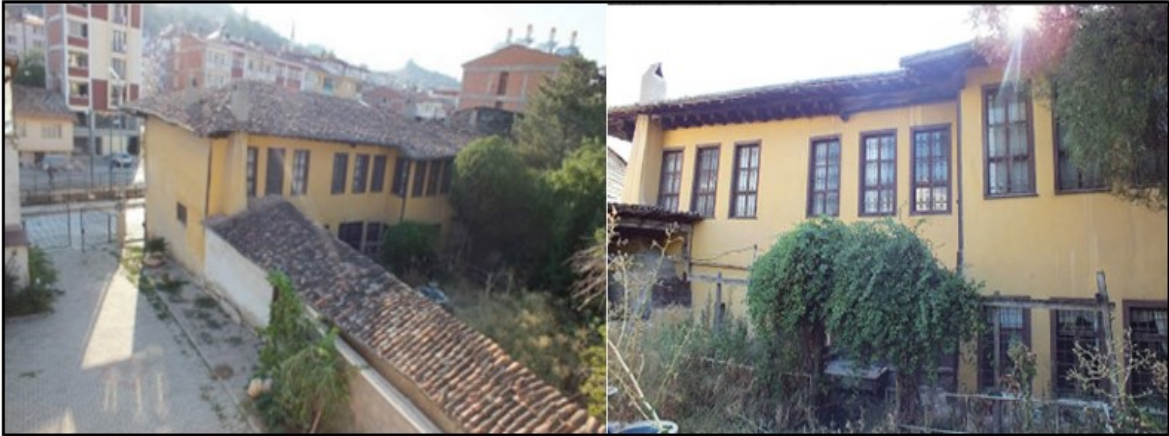
Görsel 2. Konağın Arka Cephesi (Kavukçuoğlu, 2017, URL-4)
