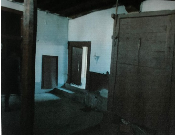
Görsel 4. Canikli Konağı Mahzen Girişi (Sivas Kültür Varlıklarını Koruma Bölge Kurulu Müdürlüğü)
