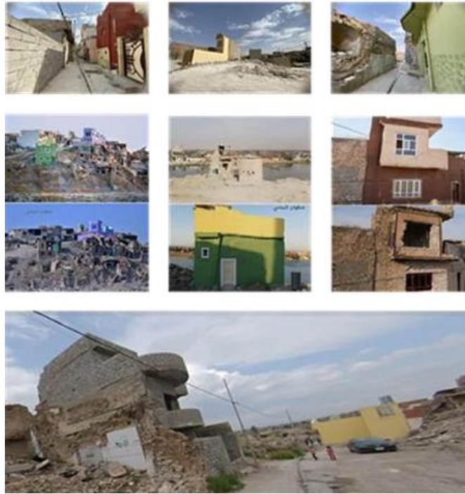
Şekil 8. İzinsiz kentsel dönüşüm yapıları (Aktürk, 2023).
