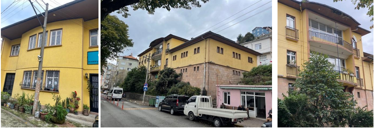
Şekil 4. Vakıf Hamamı ve oteli girişi, kütle düzeni ve balkonları (Yazarlar tarafından çekilmiştir).
