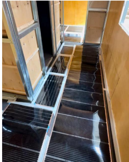
Şekil 4. Parke altı yerden ısıtma film montajı .
