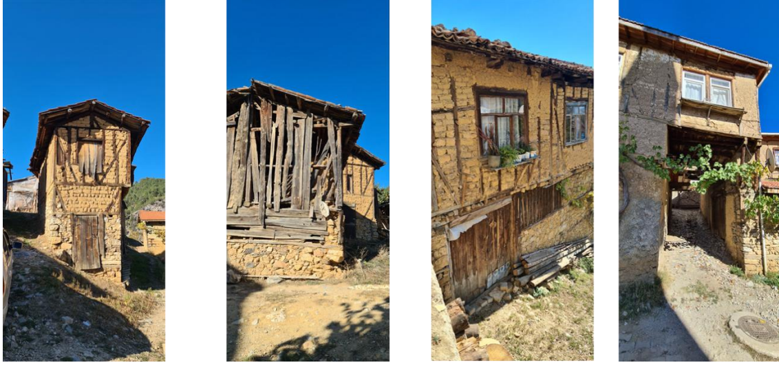
Şekil 1. Gelemiş Mahallesi'nde yapı cepheleri örnekleri (Yazarlar, 2026).
